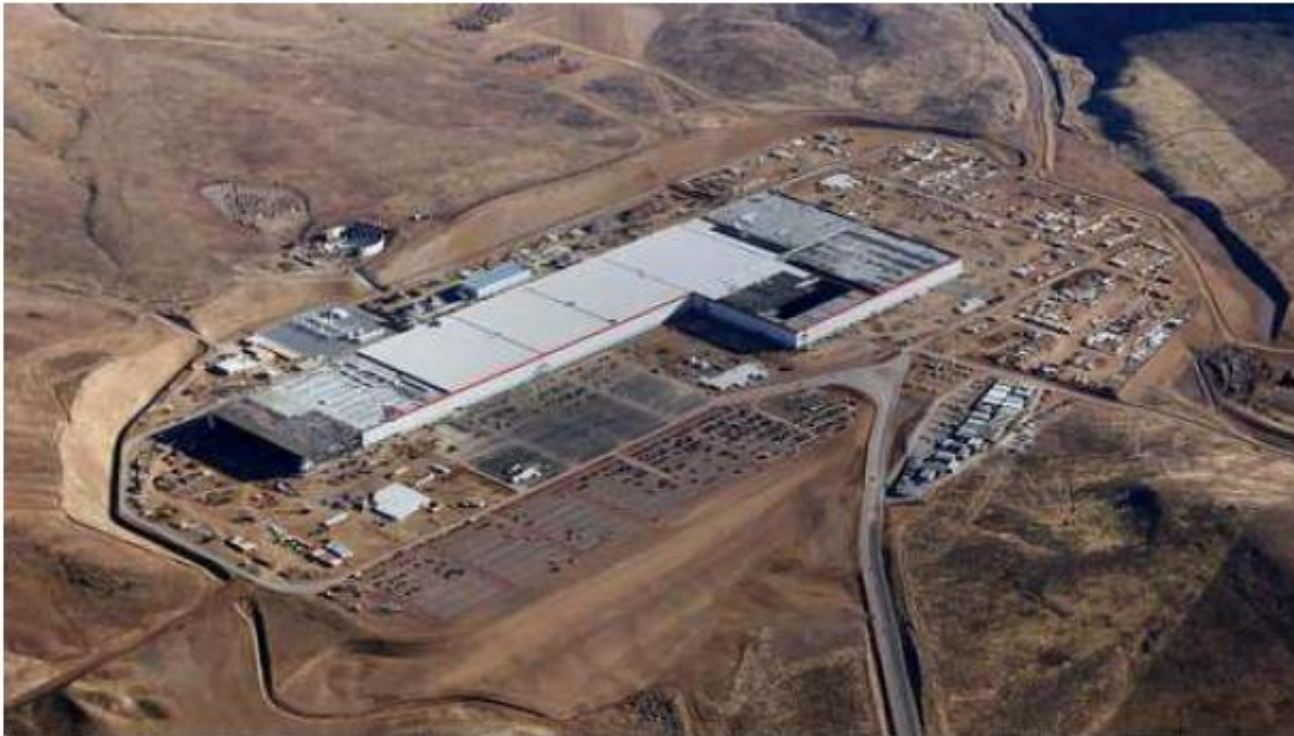
L'usine Tesla « Gigafactory » en janvier 2017 TESLA
