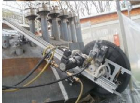
Scie circulaire diamantée robotisée pour le démantèlement des centrales nucléaires
