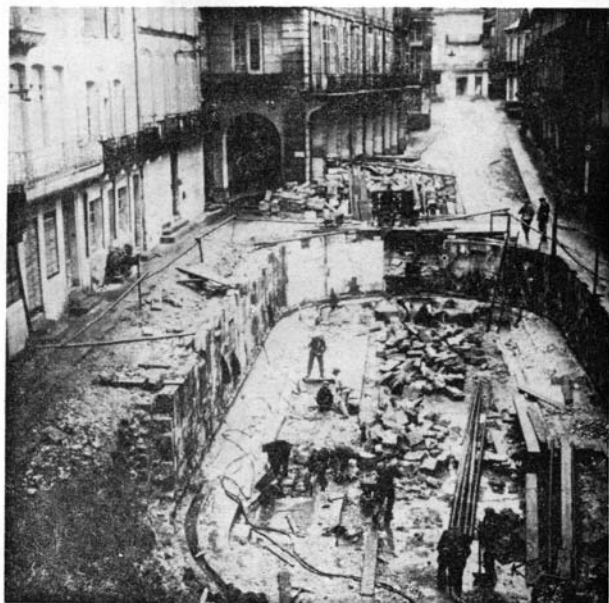
1. Plombières 1936 - Démolition du Bain Romain (Photographie Marcel Deschaseaux)
