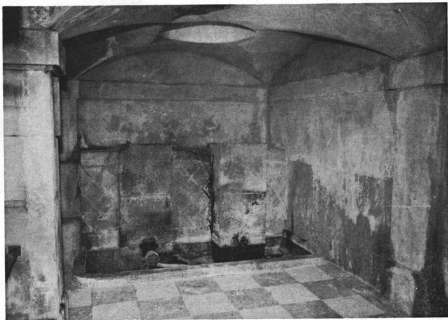
Étuve Romaine, Bain Stanislas, Robinet romain et canalisations dans les substructions romaines du bas de la pièce
