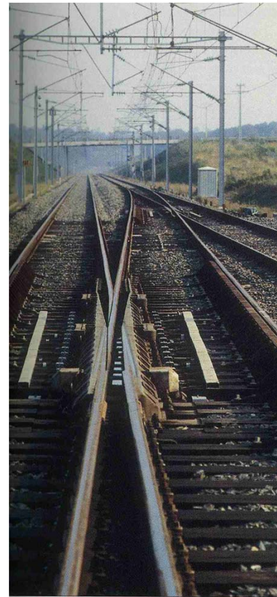
Des aiguillages nouveaux à cœur mobile
